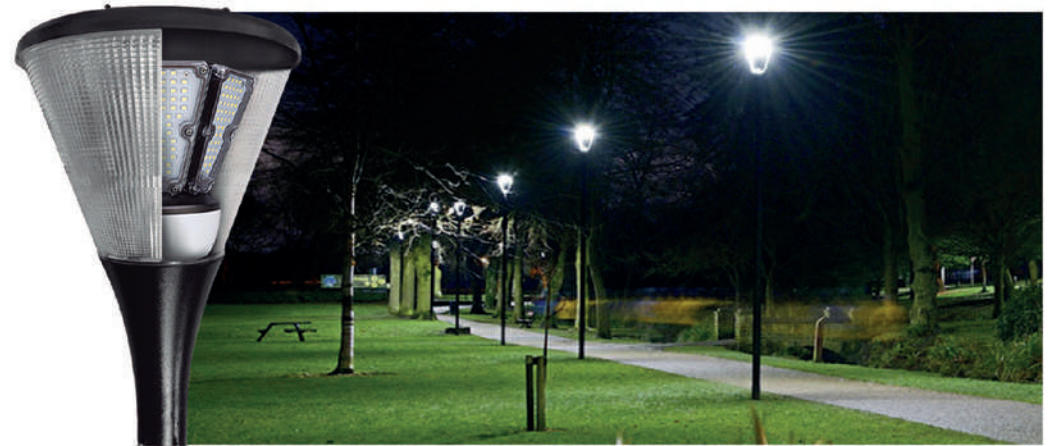
*Ejemplo de instalación punta poste
